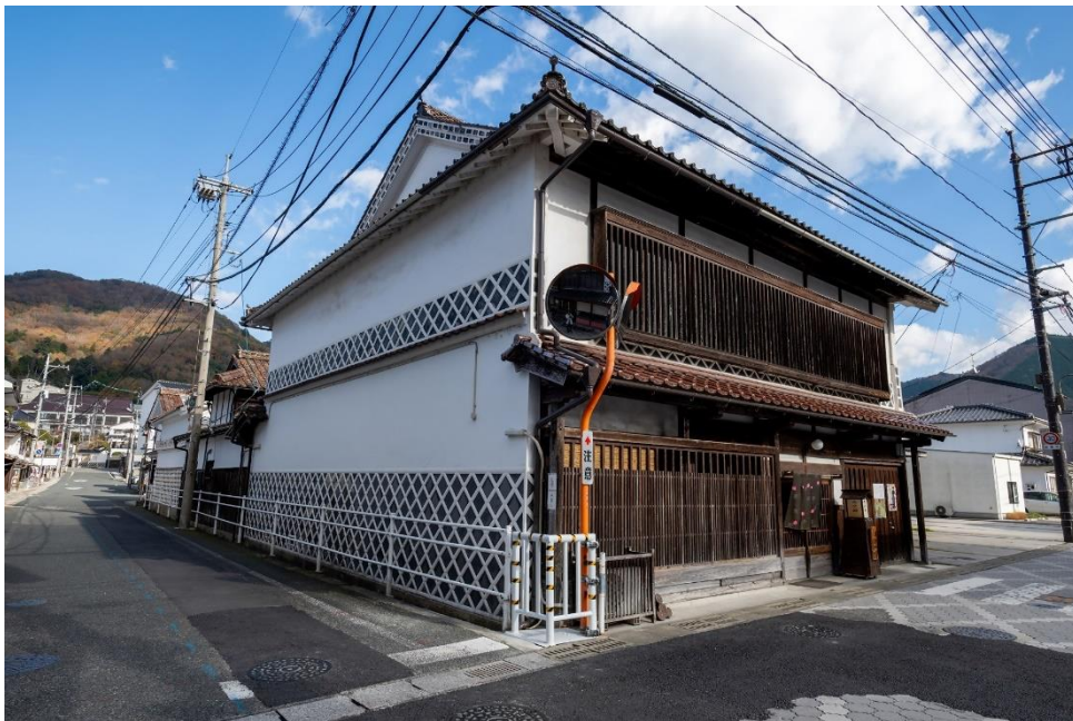
① 全景 (南西から)
