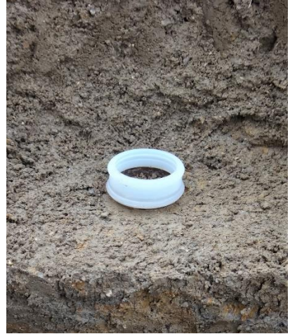
ゴムリングの取付け
