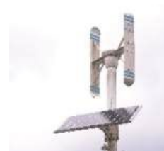
風力発電設備 (周りの照明へ供給)
