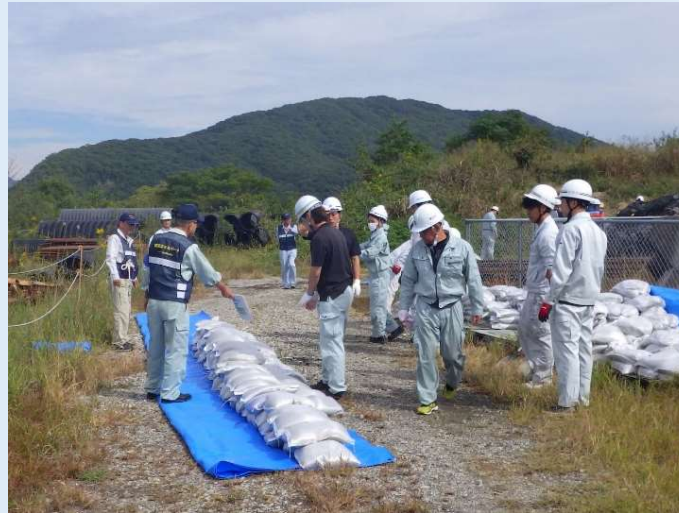
改良積み土のう工法
