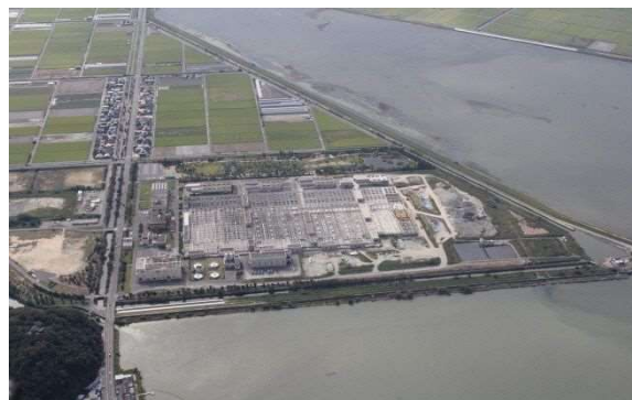
児島湖流域下水道浄化センター
