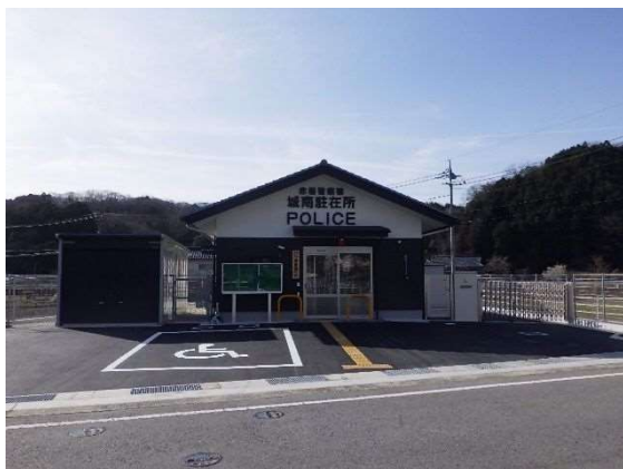
赤磐警察署城南駐在所新築工事
