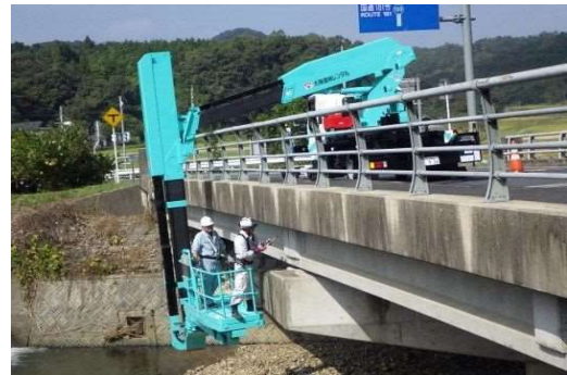
橋梁点検状況
