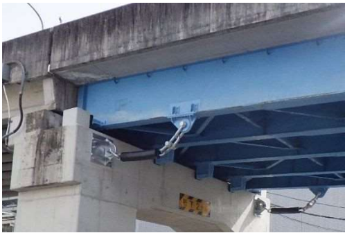
耐震補強状況
