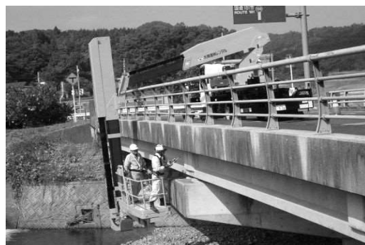
橋梁点検状況
