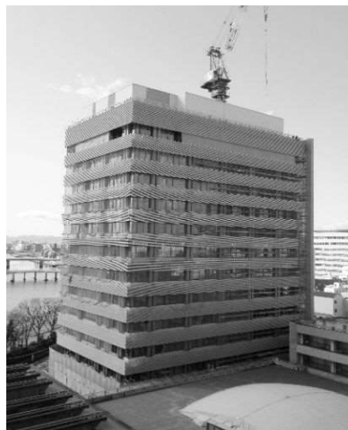
岡山県警察本部庁舎（工事中）
