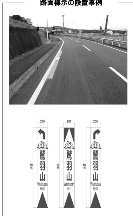
路面標示の設置事例
