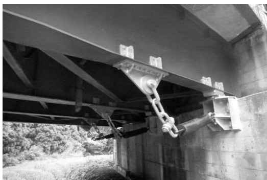
耐震補強状況
