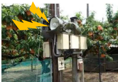
現地での設置状況
