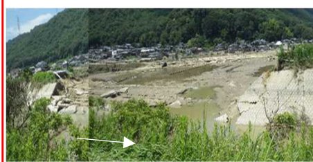
高梁川水系真谷川 倉敷市 決壊：左岸L=75m 浸水面積：約1,200ha 浸水戸数：約4,600戸
