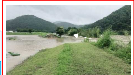
旭川水系旭川 岡山市 （北区御津国ヶ原） 決壊：左岸L=48m 浸水面積：約37ha 浸水戸数：約48戸
