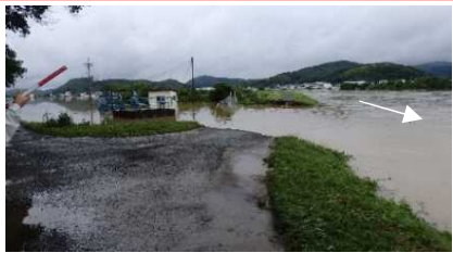
高梁川水系小田川 矢掛町 決壊：左岸L=90m : 右岸L=40m 浸水面積：約135ha 浸水戸数：約383戸
