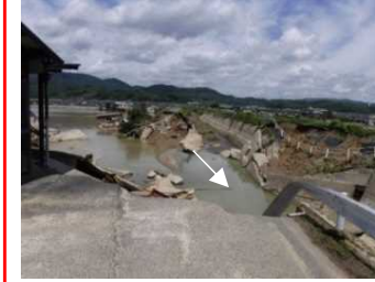
高梁川水系高馬川 倉敷市 決壊：左岸L=20m : 右岸L=55m 浸水面積：約1,200ha 浸水戸数：約4,600戸
