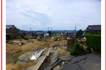
高梁川水系末政川 倉敷市 決壊：左岸L=150m : 右岸L=150m 浸水面積：約1,200ha 浸水戸数：約4,600戸
