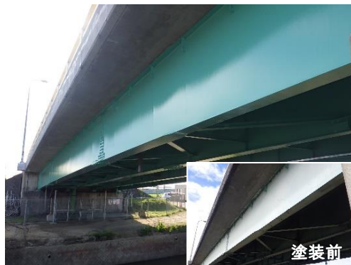
児島湾地区(岡山市南区) 【橋梁の塗装】
