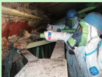
吹付け石綿の除去作業の様子
