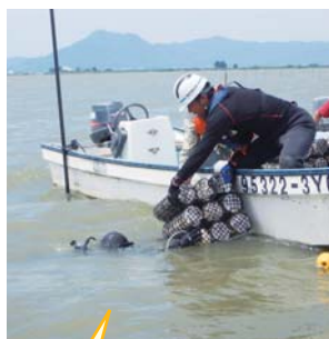
魚礁設置作業の様子
