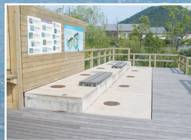
●水質浄化施設
