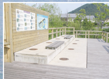
●水質浄化施設
