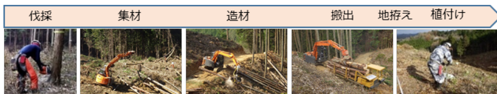
伐採・再造林の一貫作業
