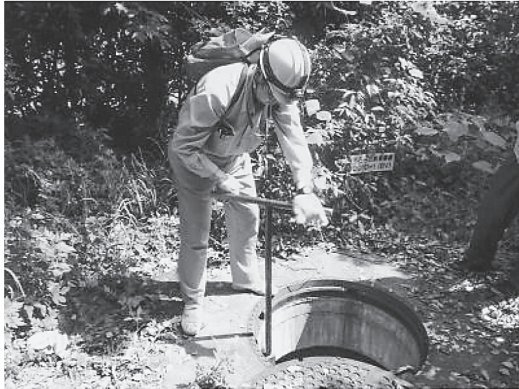
2ルート配水管路の切替作業状況
