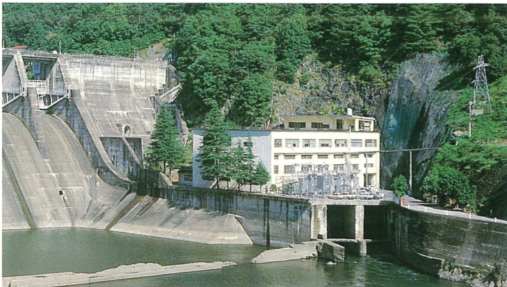
ダム直下の第一発電所
