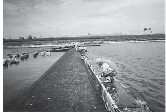
パネル設置作業状況
