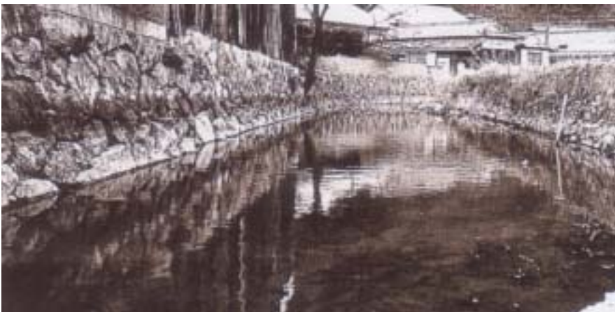
田原用水（1980年頃） 田原上（和気町）から砂川（瀬戸町）まで、およそ18kmにわたって田んぼや畑に水を送っています。
