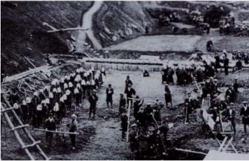
千本づき 写真の左側に列をなしている人が棒を持って土を突いている
