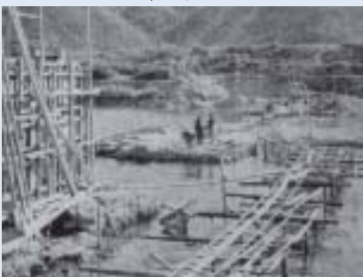
水の上で作業を行うために旭川の中に島を造ります
