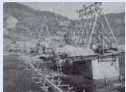
筒の中の土砂を掘削して川底へ沈めます
