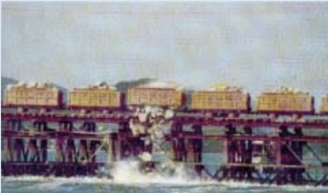
海の上にレールを敷き、捨石を行いました
