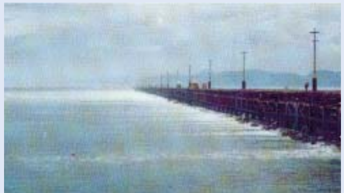
堤防の工事中は、海の干満によって捨石の間から海水が流れ込むこともありました
