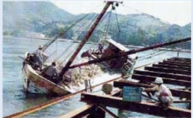
倒れながら捨石を行う転倒船も使用しました
