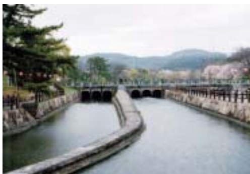
酒津配水池樋門
