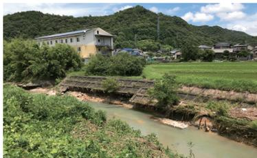
平成30年7月豪雨による護岸の崩壊 (岡山県和気町)
