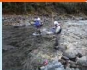
流量調査・測量作業
