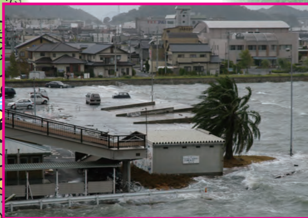
平成16年8月 笠岡市 台風第16号による高潮被害
