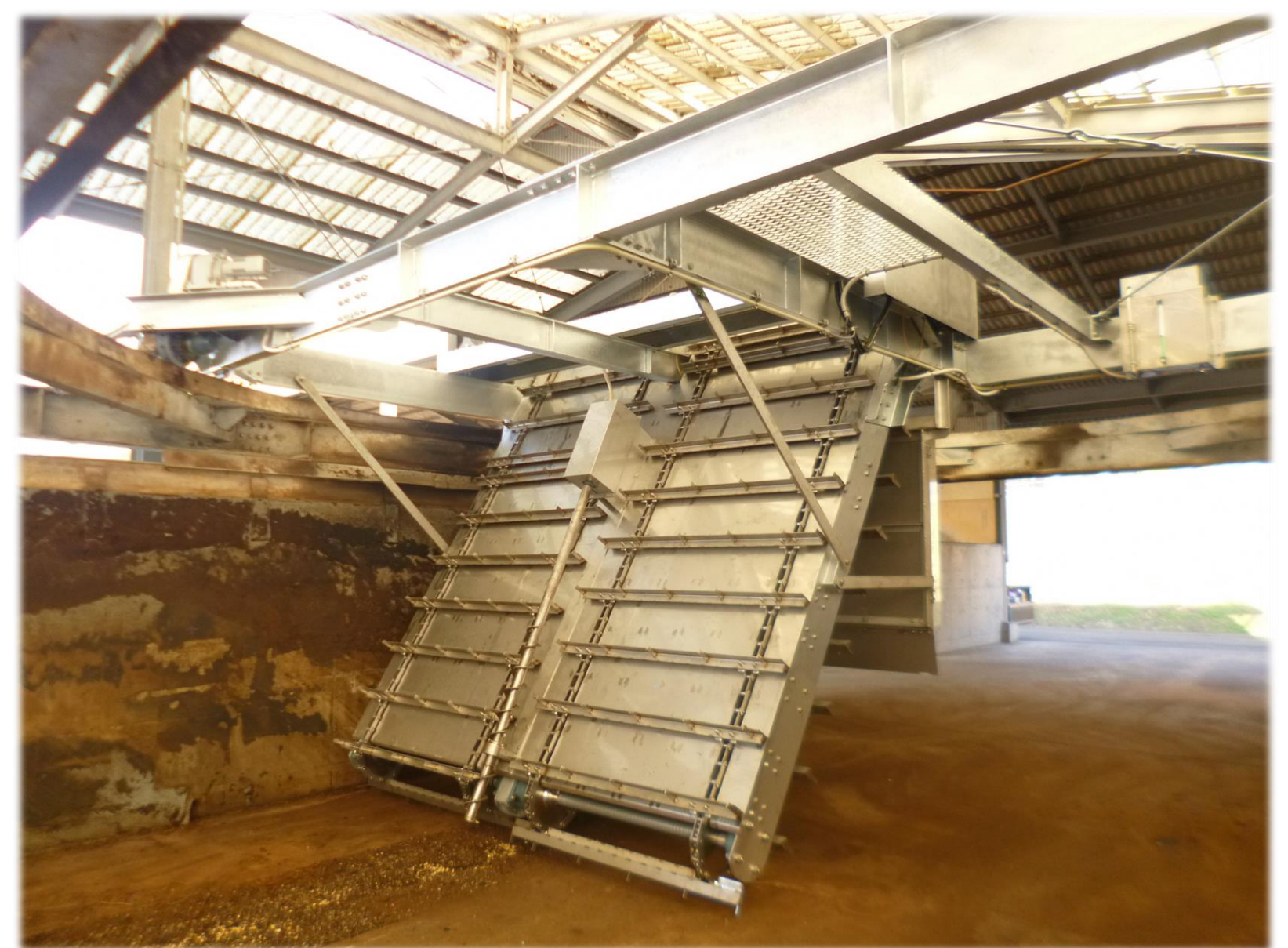
写真 改修した攪拌装置
