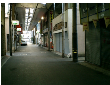
老朽化したアーケードの景観
