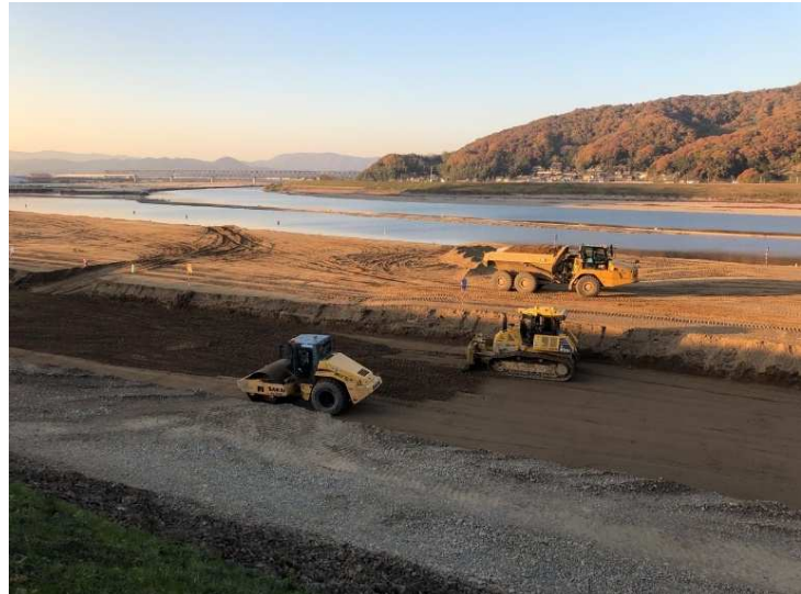
令和3年11月 締切堤防の盛土工事
