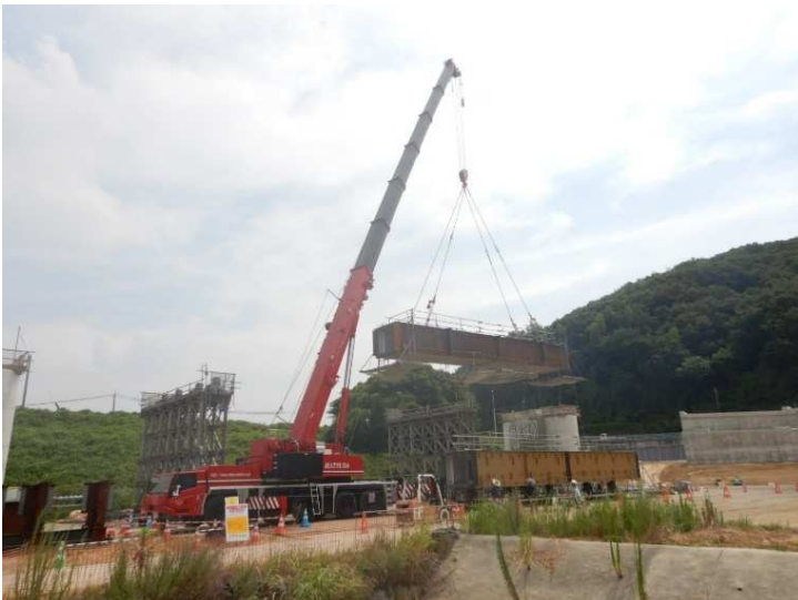
令和3年8月 橋桁の架設
