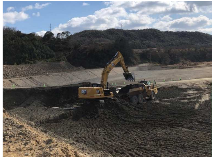
令和4年2月 酒津地区の掘削
