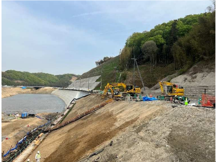
令和5年4月 南山護岸整備
