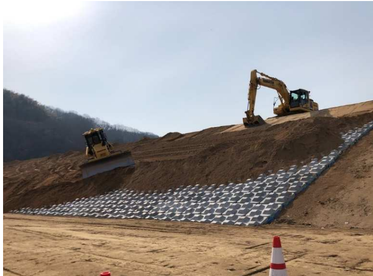
令和4年3月 締切堤防の護岸整備
