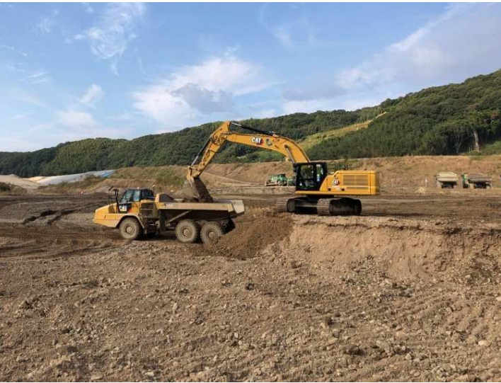
令和3年10月 酒津地区の掘削
