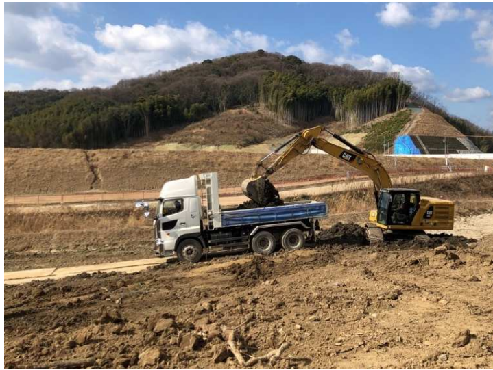
令和4年2月 酒津地区の掘削
