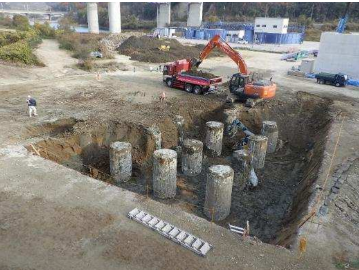
令和2年12月 橋台の基礎杭工事
