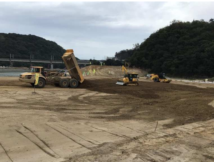
令和3年9月 柳井原地区の堤防整備
