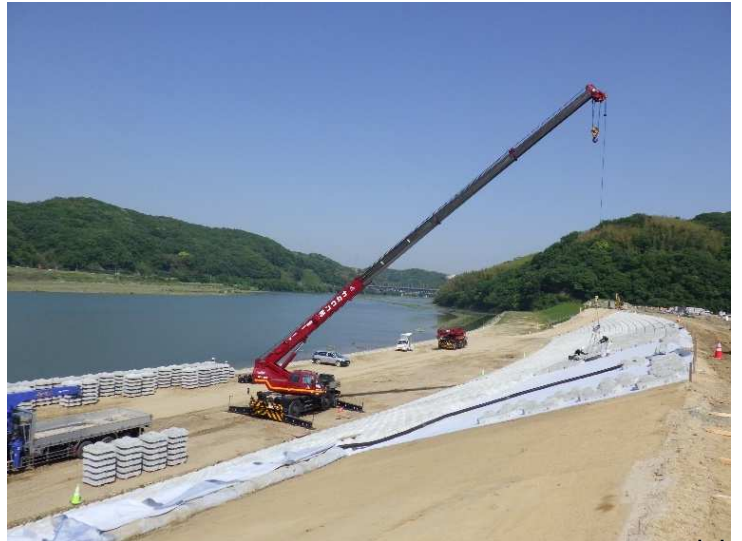
令和5年5月 締切堤防の護岸整備
