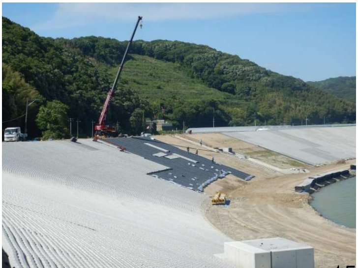
令和5年5月 柳井原地区の護岸整備
