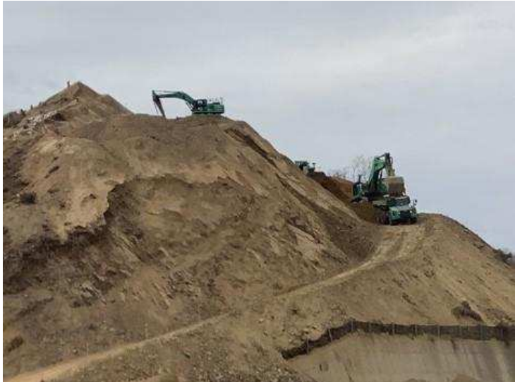
令和2年1月23日に本格的な掘削に着手
