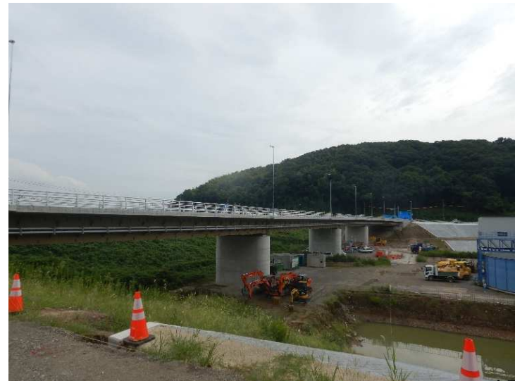
令和4年8月 橋桁架設完了
