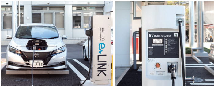
「脱炭素推進のツールのひとつ」として採用したEVは、営業車両として使用しているEVを、日々フル充電するための充電器 「V2B」の導入で非常用電源としても活用できるように
