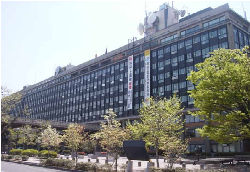
県庁統制局（地上系アンテナ：本館屋上）
