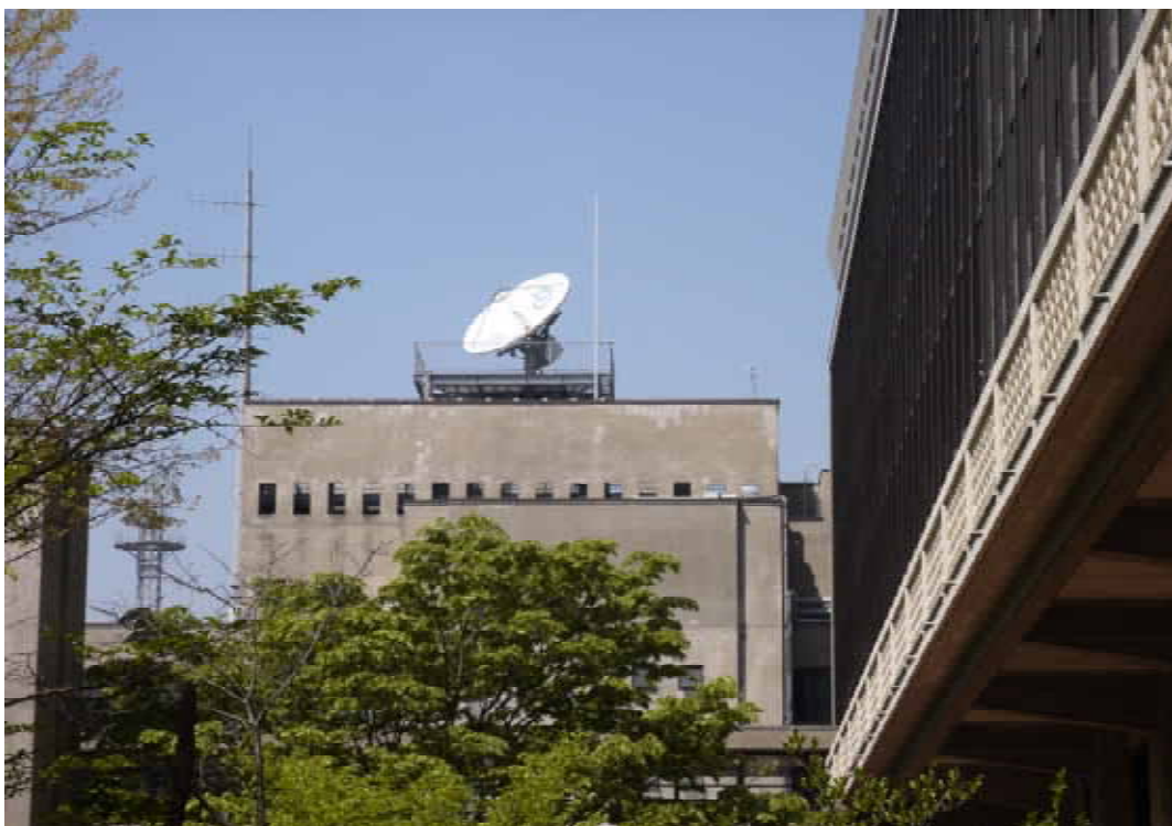
県庁統制局（衛星系アンテナ：西棟屋上）
