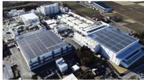
図1 栃木工場太陽光発電設備（工場棟の屋上の様子）
