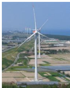
鳥取県北栄町 北条砂丘風力発電所 (出典) 鳥取県北栄町HP
