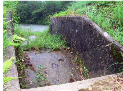
老朽化した洪水吐
