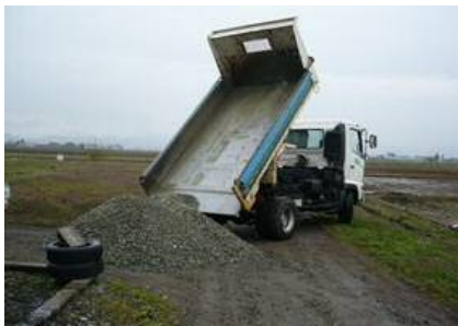
砂利の荷下ろし
