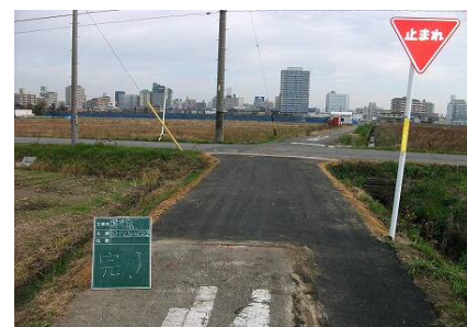
アスファルト舗装の打換え
