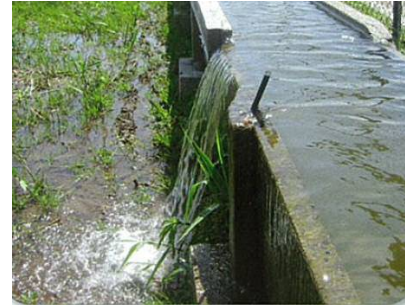
水路からの部分的な溢水
