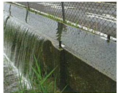
水路からの溢水
