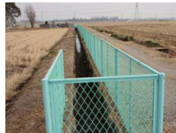
新たに設置された 金網フェンス
