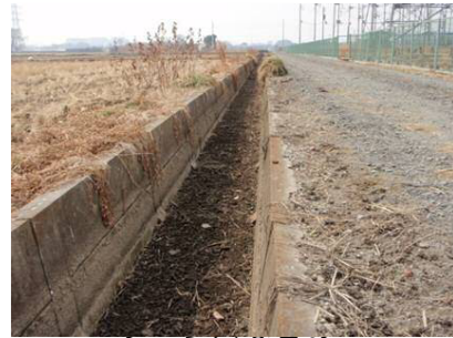
安全施設がない水路
