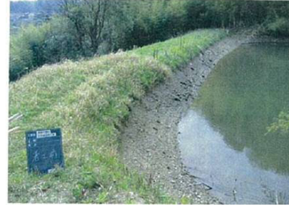
漏水が生じているため池
