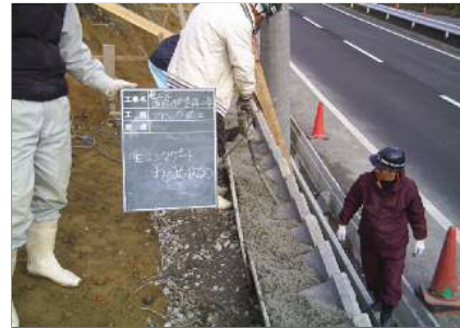
ブロック積みの施工
