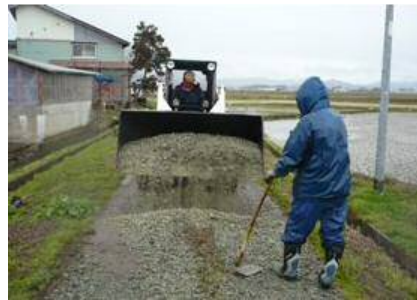
砂利の敷き均し
