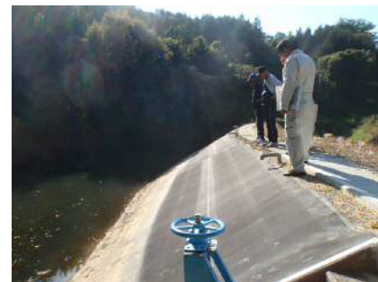
遮水シートの設置
