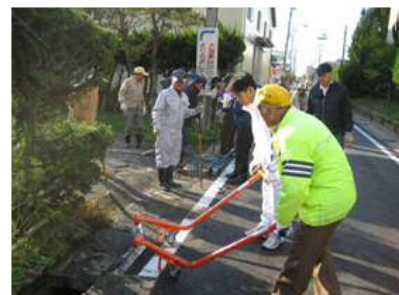
水路蓋の設置 (専用器具使用)
