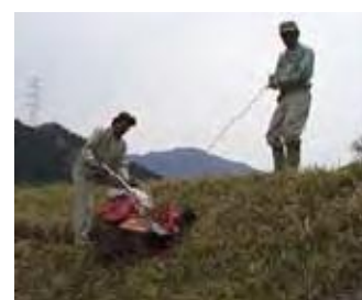
小段設置状況（掘削）
