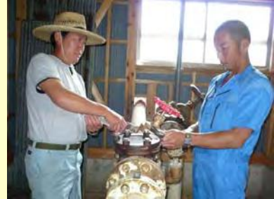
ポンプの点検状況
