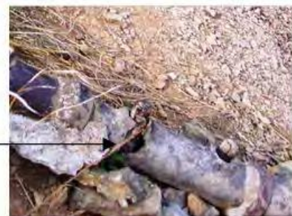
古い樋管（陶製）の破損
