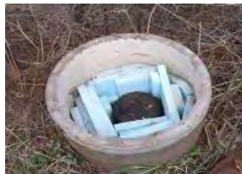
給水栓ボックス内の保温状況
