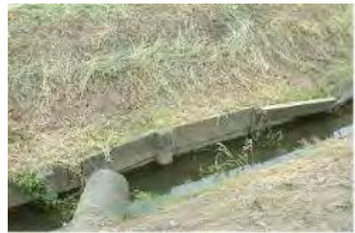
水路側壁のはらみの状況
