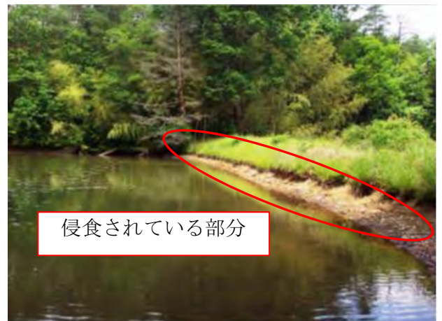
侵食が生じているため池堤体
