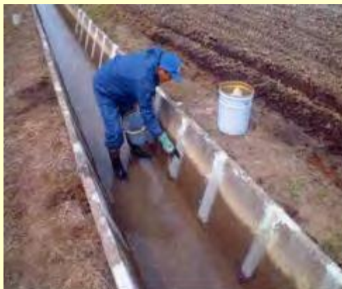
目地詰め作業
