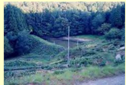
改修前のため池の様子
