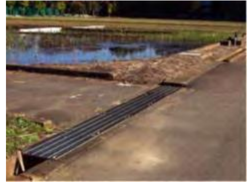
コンクリート蓋とグレーチング
