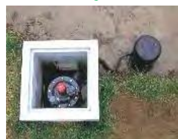
給水栓の自動化
