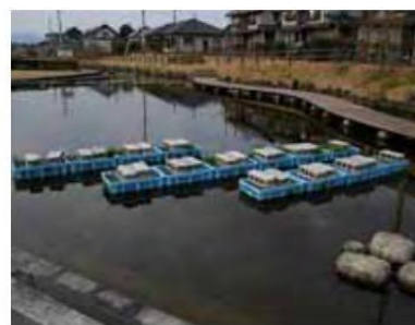
木炭浄化（接触酸化法の一つ）
