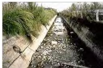
水量が減少した水路
