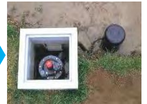
給水栓の自動化へ改良
