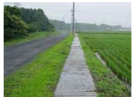
水路へのコンクリート蓋の設置
