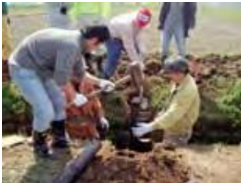
魚道の設置状況
