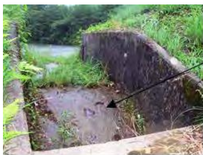
洪水吐底板（コンクリート）の欠損
