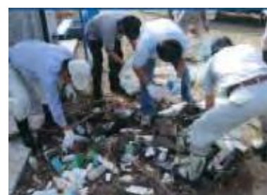
ゴミ・土砂の除去状況
