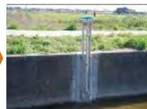
巻き上げ式ゲート
