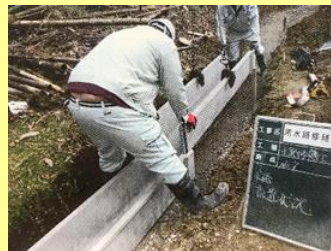
水路の据付作業
