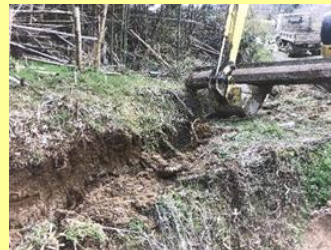
既設水路撤去作業
