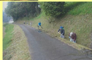
水路の泥上げ
