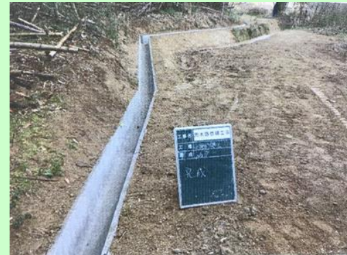
【R2年度実績】水路本体の更新 約150m
