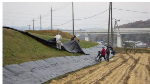
防草シート設置
