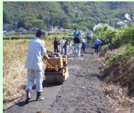
未舗装農道の舗装
