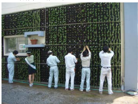
植栽中の状況
