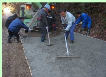
直営施工によるため池管理道の舗
