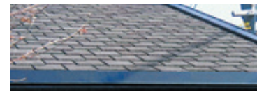
石綿含有住宅化粧用スレート(屋根)
