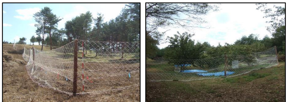
図-105 中古ノリ網による防護柵の設置 事例4（県森林研究所内）
