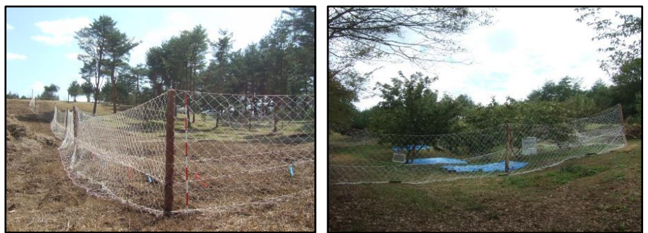
図-105 中古ノリ網による防護柵の設置 事例4（県森林研究所内）
