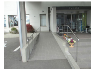
出入口の段差解消 事業費：30万円程度
