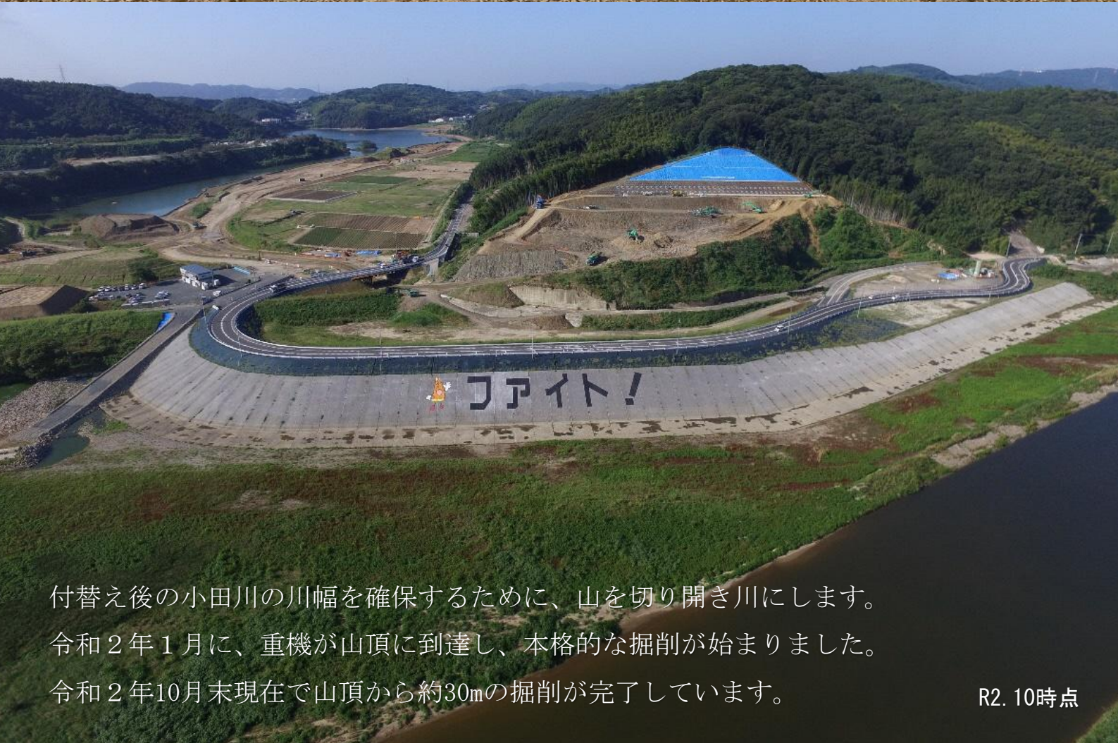
南山の掘削状況
