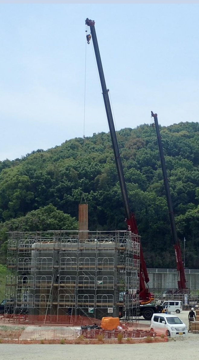
橋脚部分の鉄筋組立
