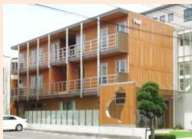
CLTを活用した木造建築物
