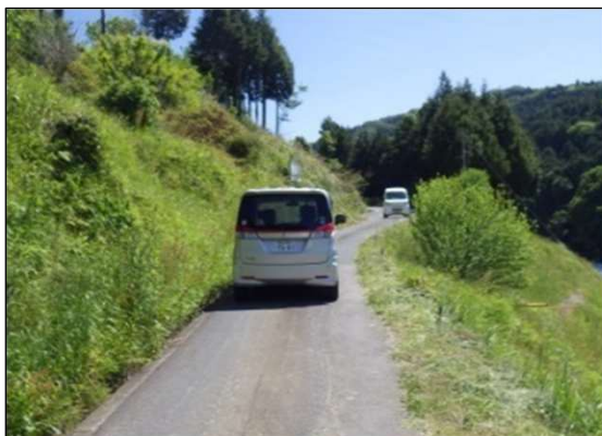
【県道栃原久米南線(現況)】
