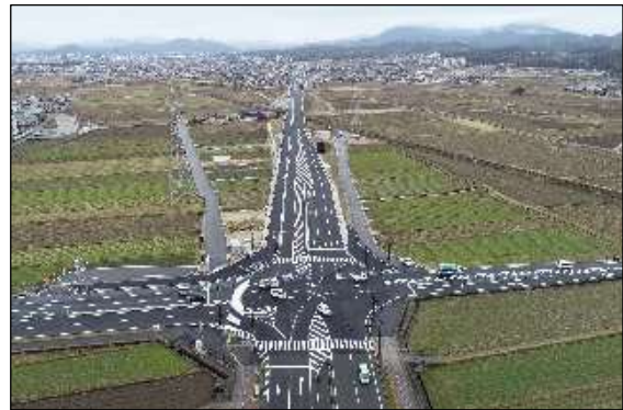
【国道180号総社・一宮バイパス(令和4年度開通箇所)】
