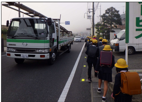
【国道313号(真庭市)(整備中)】
