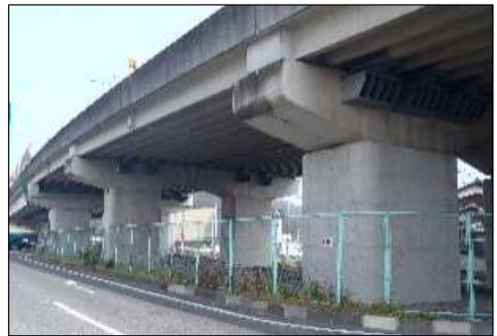
【県道藤戸連島線 連島高架橋(耐震補強)】
