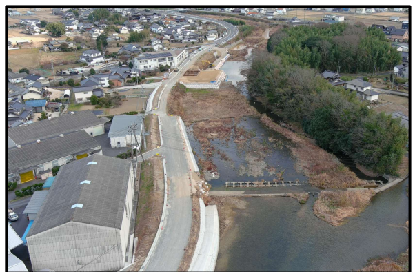
【県道東水砂矢掛線(整備中)】
