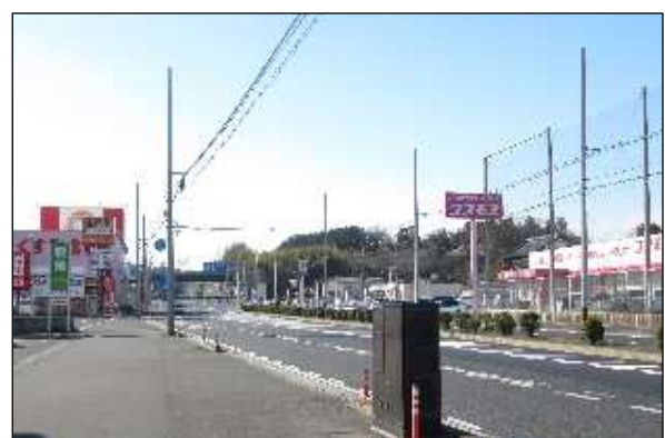
【国道179号(入線作業中)】
