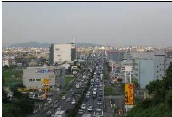
【国道2号(岡山市～倉敷間)(現況)】
