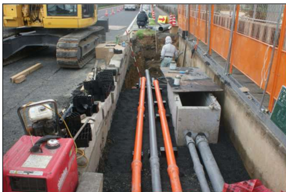
【国道179号(管路整備状況)】
