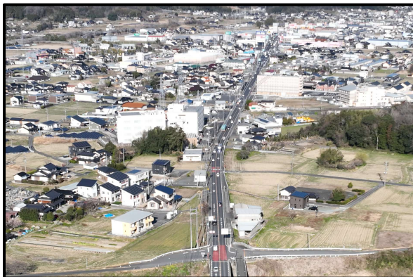
【国道181号神戸拡幅(整備中)】
