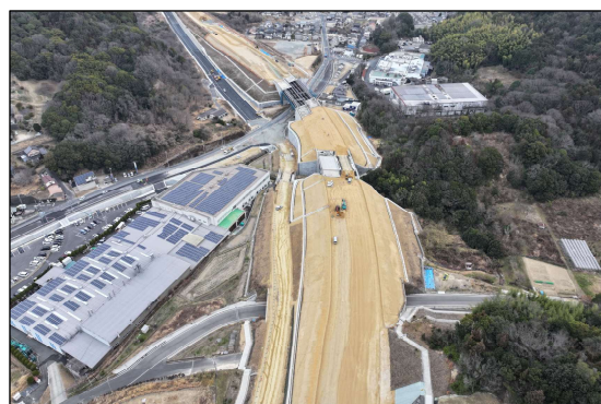
【倉敷福山道路(里庄IC付近整備中)】
