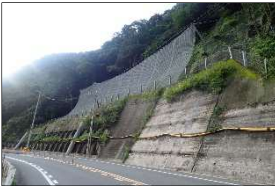
【国道180号(落石対策)】
