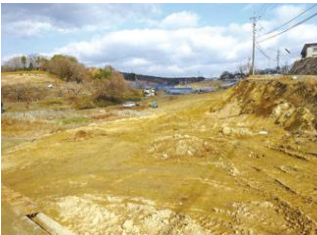
完成間近の大規模研修ほ場 (機械化に対応できるよう大区画で勾配を緩くした)
