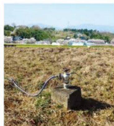
美作台地とかんがい設備
