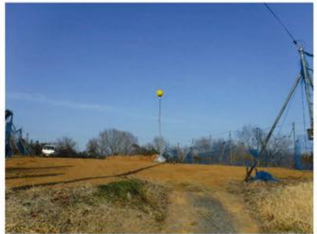
工事後(勝央町、抜根した後に整地)
