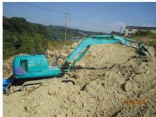
簡易整備の状況（もも栽培に適さない土が表面に出ていて、大きな石もたくさん埋まっていた）
