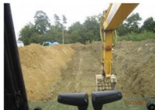
簡易整備の状況（右側がもも栽培に適さない土、左側が新しく投入する土。表土を1m取り除き、新しい土を投入）
