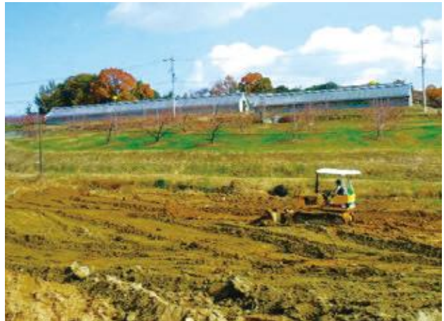
水田転換では排水対策を徹底した（整備中）
