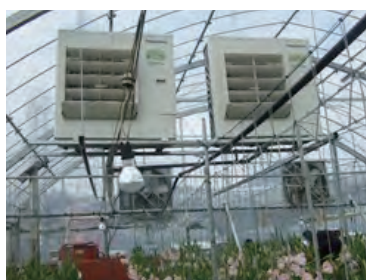
ヒートポンプによる現地実証
