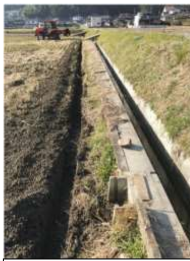
額縁明きよの施工
