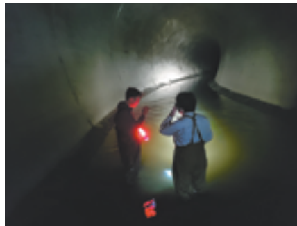
苦田ダム転流工（実験活動）
