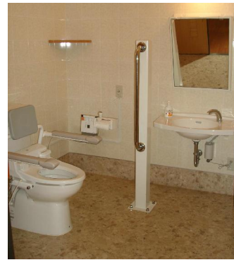
3階 車いす便所
