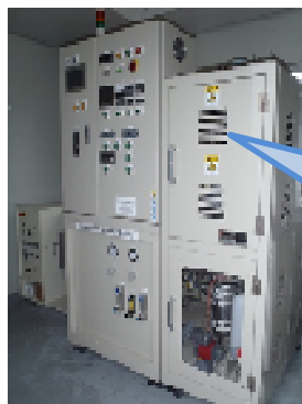
固体酸化物型燃料電池システム
