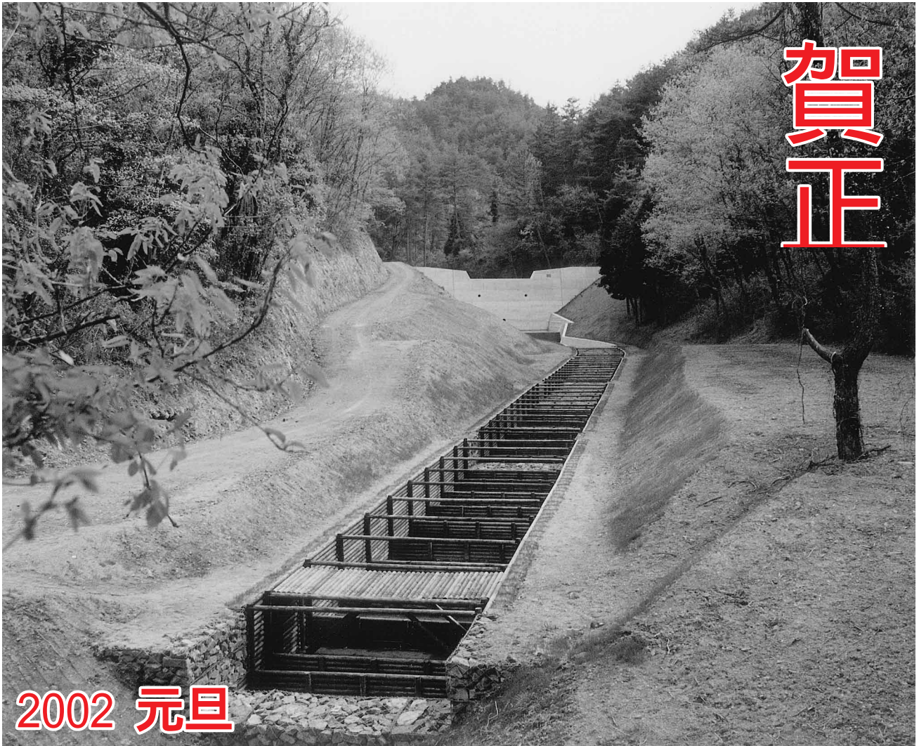
地域の木材利用施設「予防治山事業 木製流路工」(瀬戸町)
